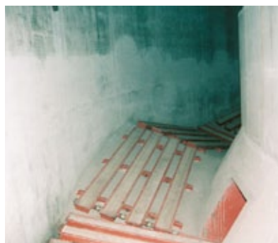
Вид днища 2-секционного силоса изнутри
