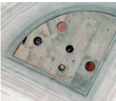
Вид крыши 4-секционного силоса изнутри
