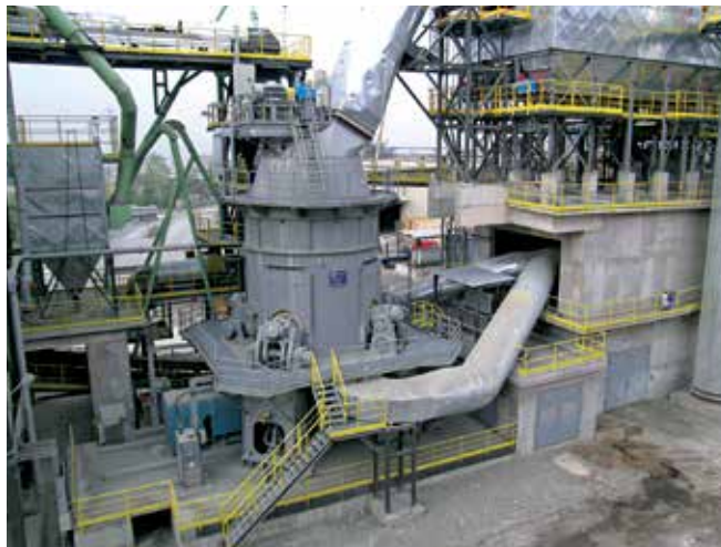
Instalação de um moinho OK™ 30-4
