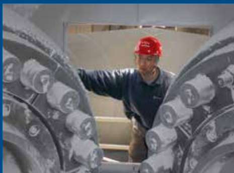
Inspeção do moinho de escória.
