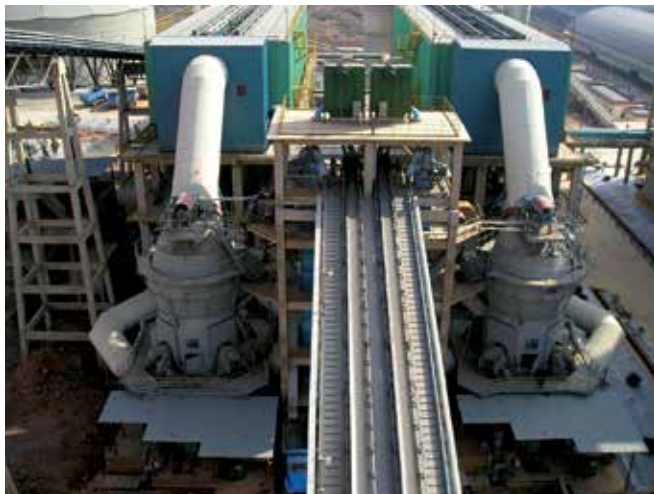
Instalación de molino gemelo
