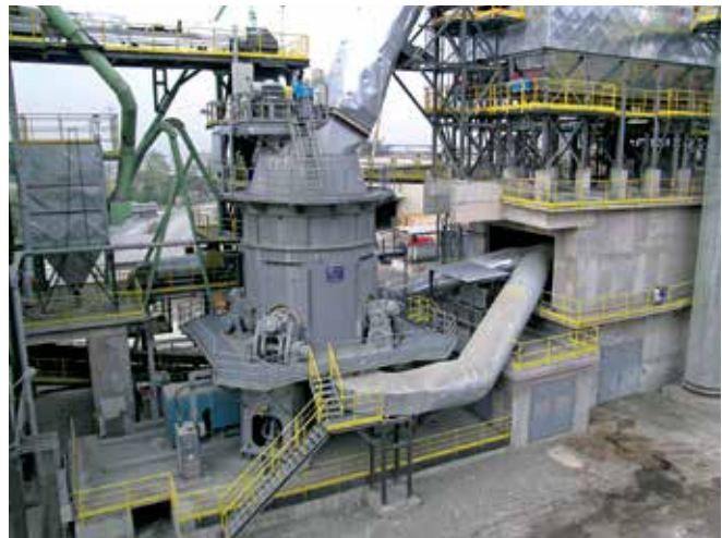
Instalación de OK™ 30-4
