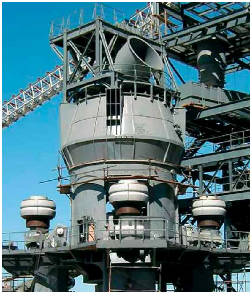
Molino OK™ 36-4 en construcción
